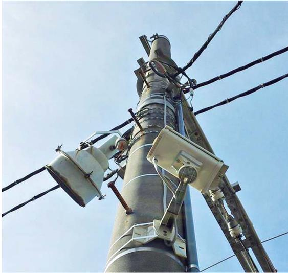
監視カメラを設置し、撮影したデータをメモリカードに保存します。そして運転士から「走行中に踏切付近で異常を感じた」などの報告があった場合、該当する踏切の撮影データを確認して状況を調査します。
