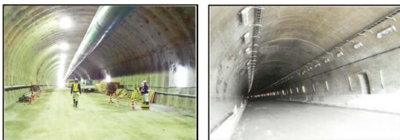
図1 左：吹き付け面，右：打設後面（佐藤工業提供）
