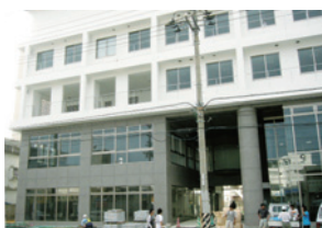
第二データセンター(沖縄県)
