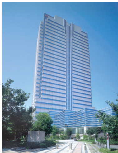
日本ユニシス本社ビル
