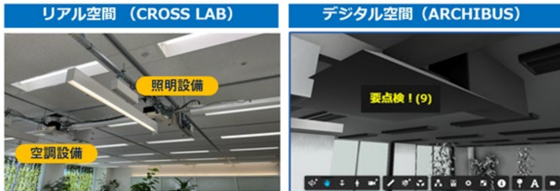
<図3：センサー情報による設備警告表示>
