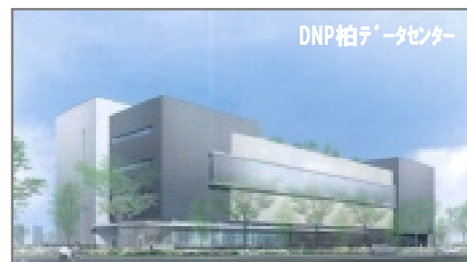
延床面積 10,580平米(850ラック)
