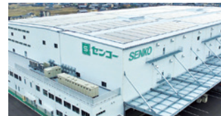
2021年5月開設のセンコー(株)の太陽光発電設備PPAで導入した「岐阜羽島PDセンター」
