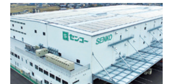
2021年5月開設のセンコー（株）の太陽光発電設備PPAで導入した「岐阜羽島PDセンター」
