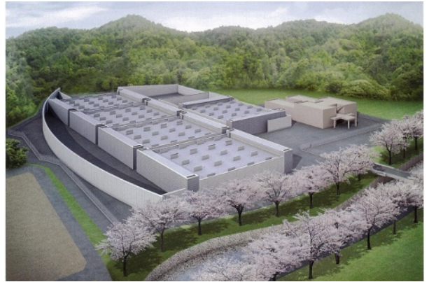
(※) PUE (Power Usage Effectiveness) : データセンターのエネルギー効率を示す指標。PUEの値が小さければ小さいほど、電力消費の割合が小さい。一般的なデータセンターは2.0~3.0
